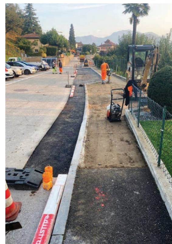
Strada Regina sud, posteggi e marciapiede
