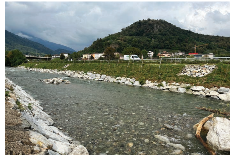
I nuovi argini del Fiume Vedeggio (© Oikos, Bellinzona)
