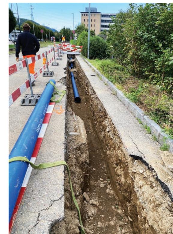
Posa dei tubi acqua potabile in zona Pobiette
