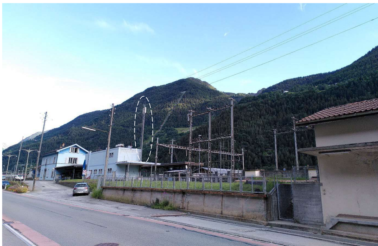
Antenna presso la stazione di Ambri-Piotta (30 giugno 2021)
