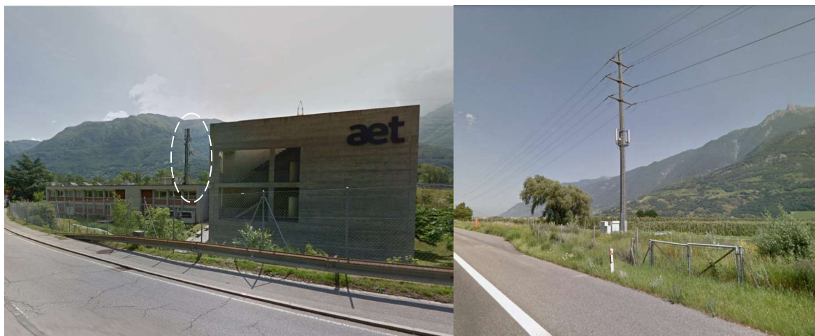
Antenna sulla sede di AET a Monte Carasso, poco distante dalla centrale elettrica e antenna su palo dell'alta tensione lungo l'autostrada a Fully (Google maps, 2019)
