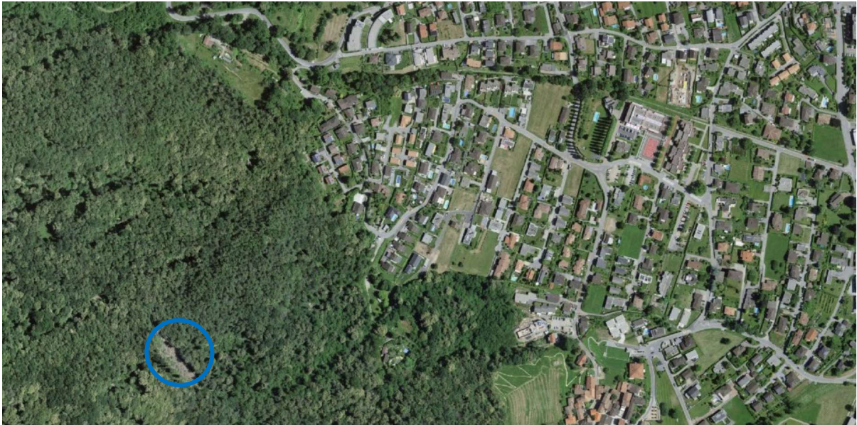
Palo dell'alta tensione che sovrasta la parte alta del Comune di Manno (map.geo.admin.ch, 2018)
