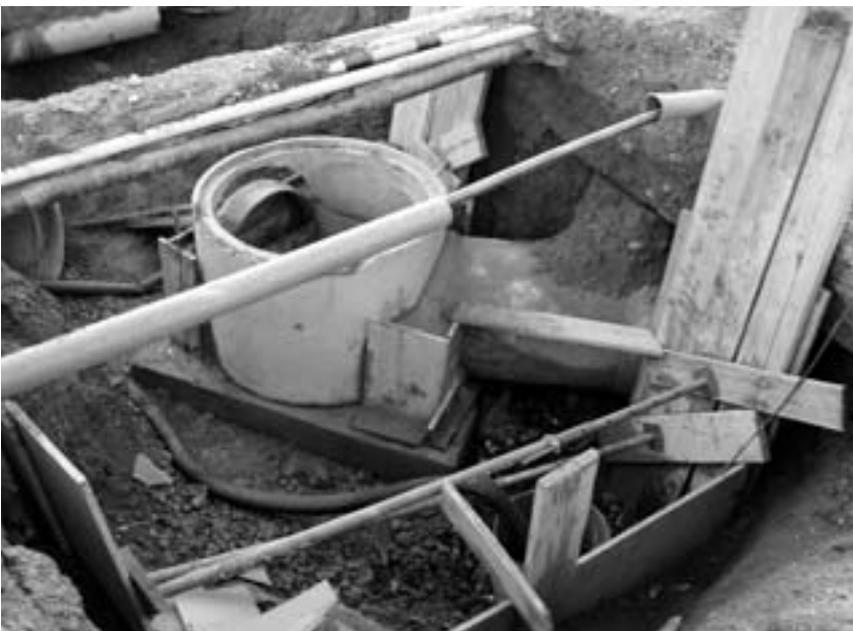
*Sotto la nuova rotonda è stato posato un nuovo collettore per la raccolta delle acque meteoriche.*
