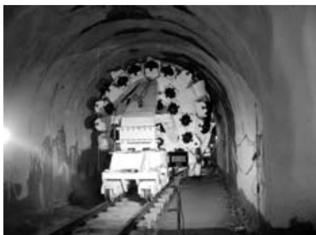
La lunghezza della TBM, compreso il treno di servizio (sul quale sono installate le infrastrutture relative al suo funzionamento, alla messa in opera delle misure di sicurezza e all'esecuzione di lavori immediatamente dietro il fronte di scavo), è di circa 200 m.
