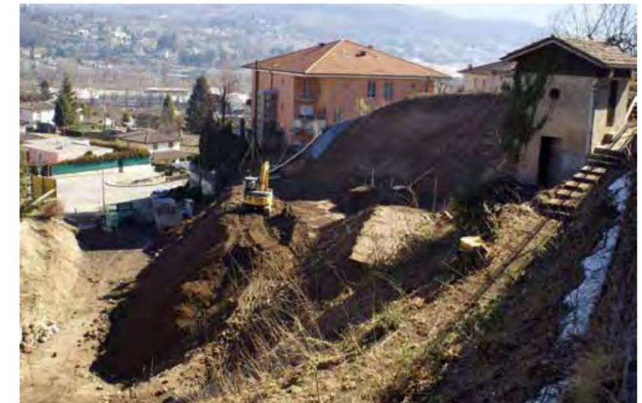
Oltre 6'000 m<sup>3</sup> di terreno verranno rimossi per dar spazio al nuovo autosilo che si svilupperà su tre piani e che avrà una capienza di 60 posti auto. Le operazioni di scavo e di ancoraggio del terreno termineranno a fine maggio. I primi getti di calcestruzzo, con la posa della platea sono previsti per inizio giugno. Salvo imprevisti l'autosilo sarà agibile a partire dal mese di maggio del 2013.
