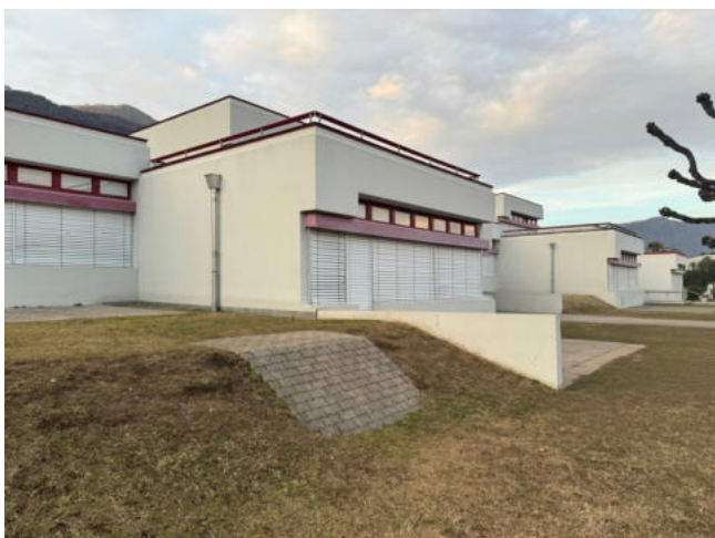
Esterni e facciate
